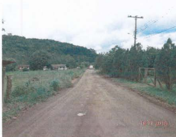
Trecho intermediário para NE (est. 13)
